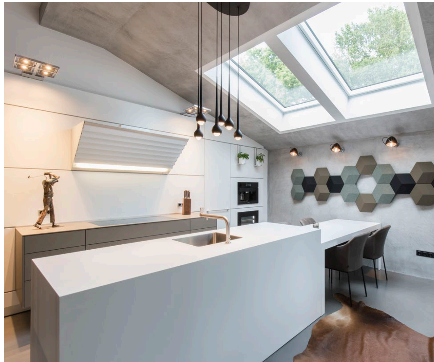
Spachteltechnik in Beton im Decken- und Wandbereich
